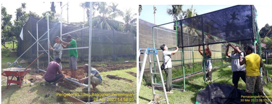
Gambar 11. Konstruksi bangunan Persemaian yang sedang di tutupi paranet
